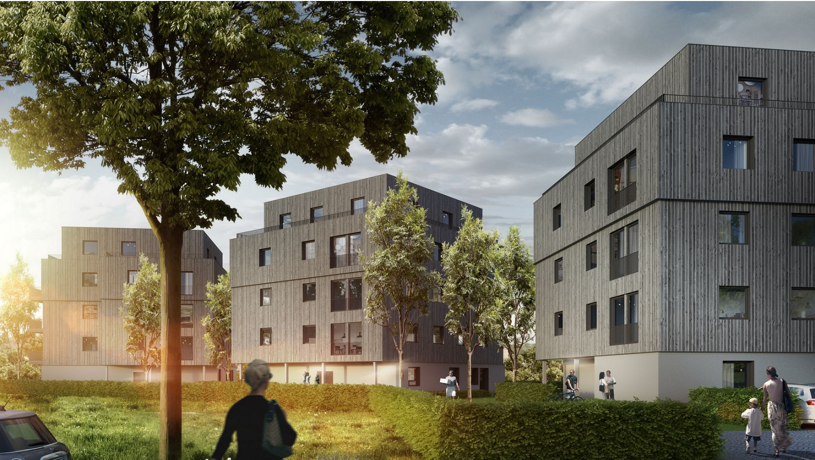
Adlershof in Berlin - ein erfolgreiches Beispiel für Urbanen Holzbau in Holz-Hybridbauweise. Foto: Björn Rolle.
