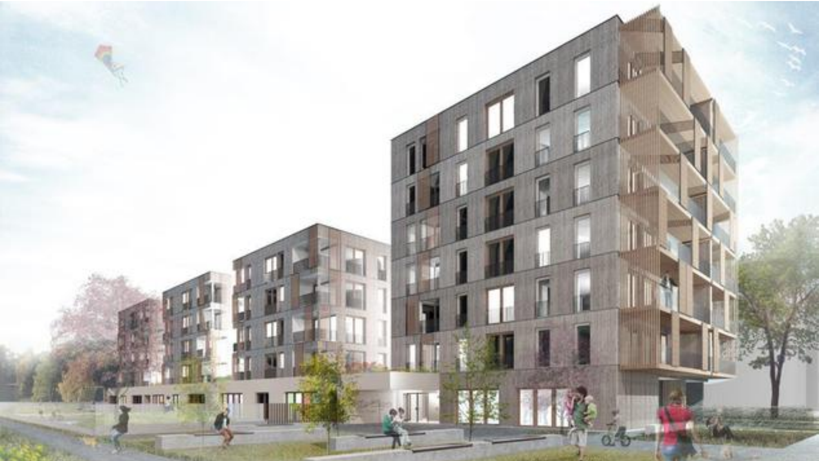
Der Holzbau im Prinz-Eugen-Park München, Bild: Rapp Architekten, mit Müllerblaustein Holzbauwerke und Brüggemann Holzbau
