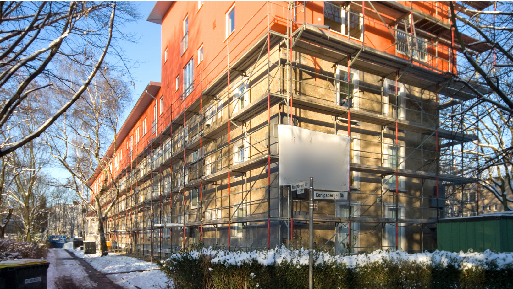
Foto: BAUEN MIT HOLZ /Markus Bollen
